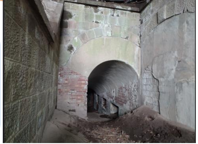
御殿山第1砲台跡
